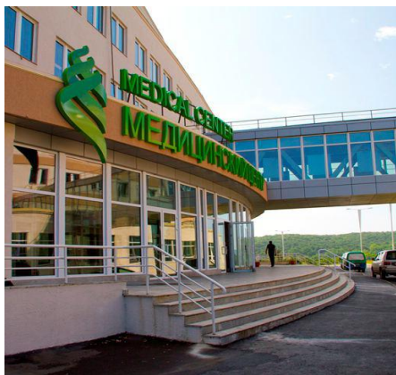
Медицинский лечебный и научно-исследовательский центр и учебный корпус медицинского блока Дальневосточного федерального университета (Медицинский центр ДВФУ) о. Русский, Приморского края.
